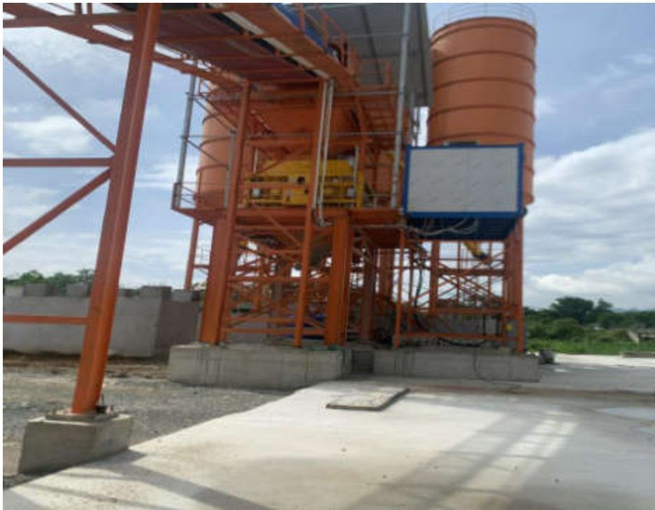
KV xả bê tông
